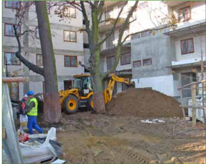
Fot. 3. Zagęszczenie gleby powodowane przez poruszanie się ciężkiego sprzętu w systemie korzeniowym drzew. Fot. MS
