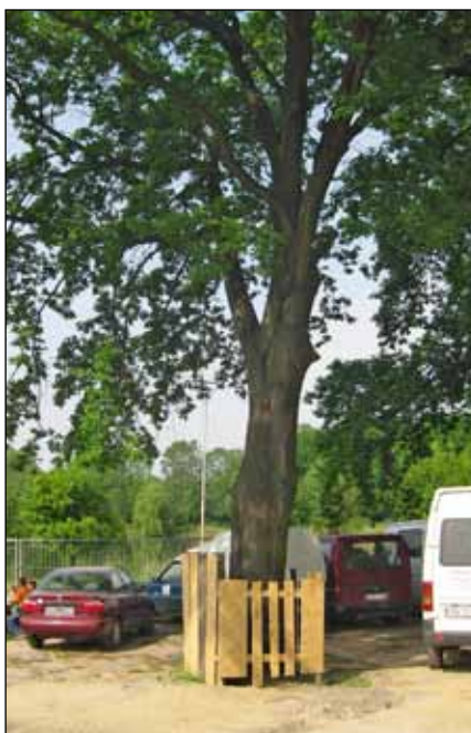
Fot. 4. Nieprawidłowo zabezpieczone drzewo na placu budowy. Fot. Monika Ziemiańska
