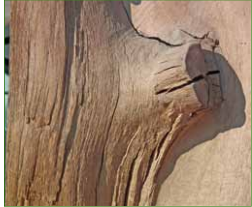
Fot. 3. Nawet po wielu latach widoczne jest miejsce uprzednio zranione. Fot. J. Borowski
