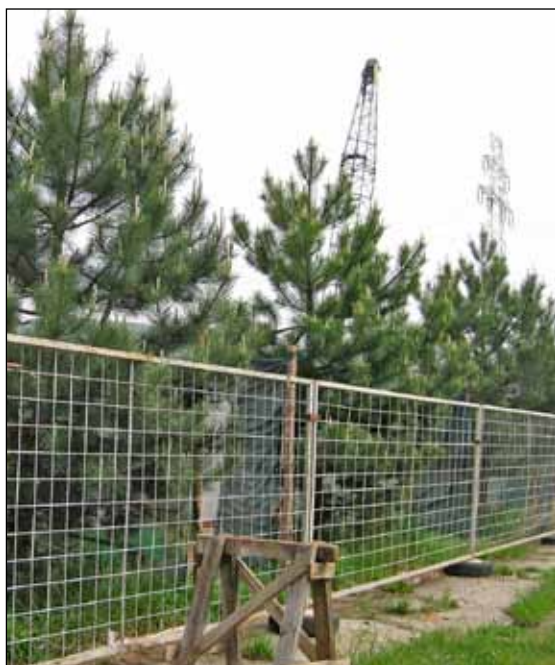
Fot. 3. Prawidłowo wygradzone drzewa na placu budowy. Fot. Monika Ziemiańska
