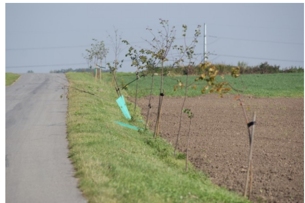
Fot. Na zdjęciu widoczny zróżnicowany stan alei. Widać drzewa najechane, połamane oraz z wielopienną formą drzewa – należy przeprowadzić konserwację alei.
