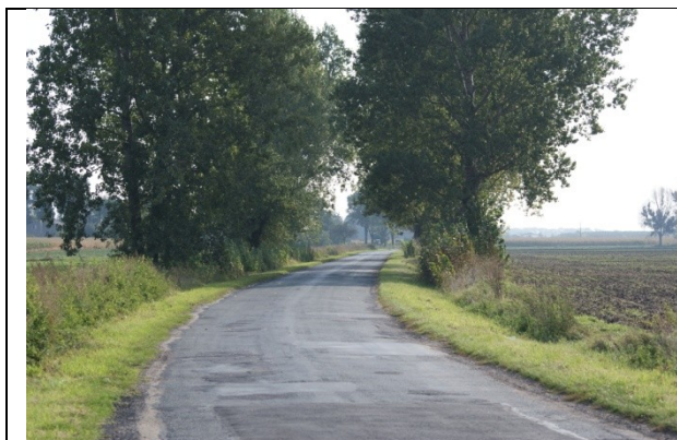
Fot. 1 Widok drogi w kierunku miejscowości Sulimów
